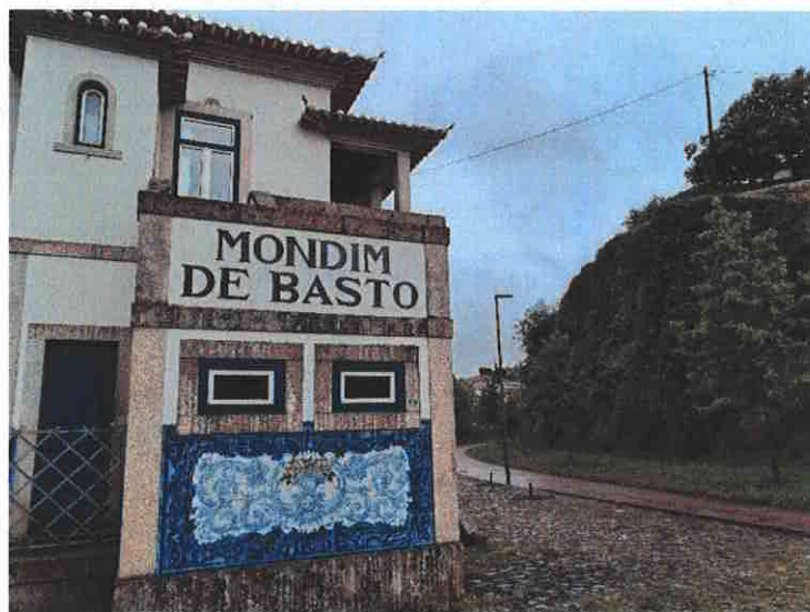
Foto 1: Estação de Mondim de Basto (6.ª reunião da Rede de Parceiros das Ecopistas de Portugal)
