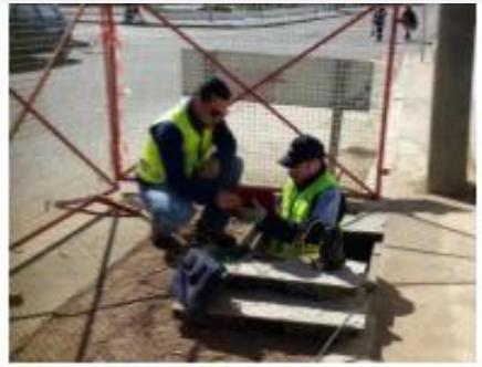
Imagem 8. Instalação de telemetria no contador da ZMC
