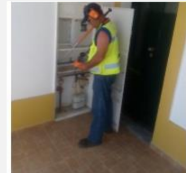
Imagem 5. Deteção de fugas na ZMC
