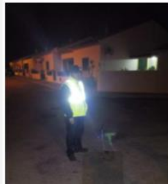
Imagem 9. Trabalhos noturnos na deteção de fugas
