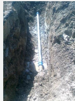
Imagem 11. Reparação de Fugas Detectadas
