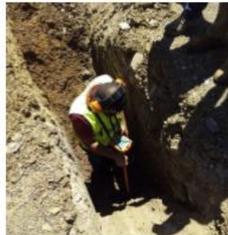
Imagem 3. Pesquisa de água de fugas no subsolo
