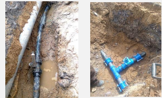
Imagem 7. Reparação de Fugas Detectadas
