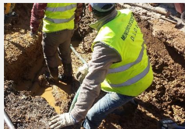
Imagem 11. Reparação de Fugas Detectadas
