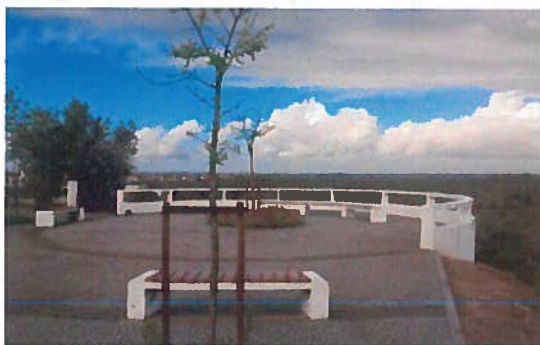
Figura 42 - Construção de Miradouro em Pavia (Mora)
