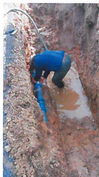
Figura 7 - Reparação de rotura em Reguengos de Monsaraz.
