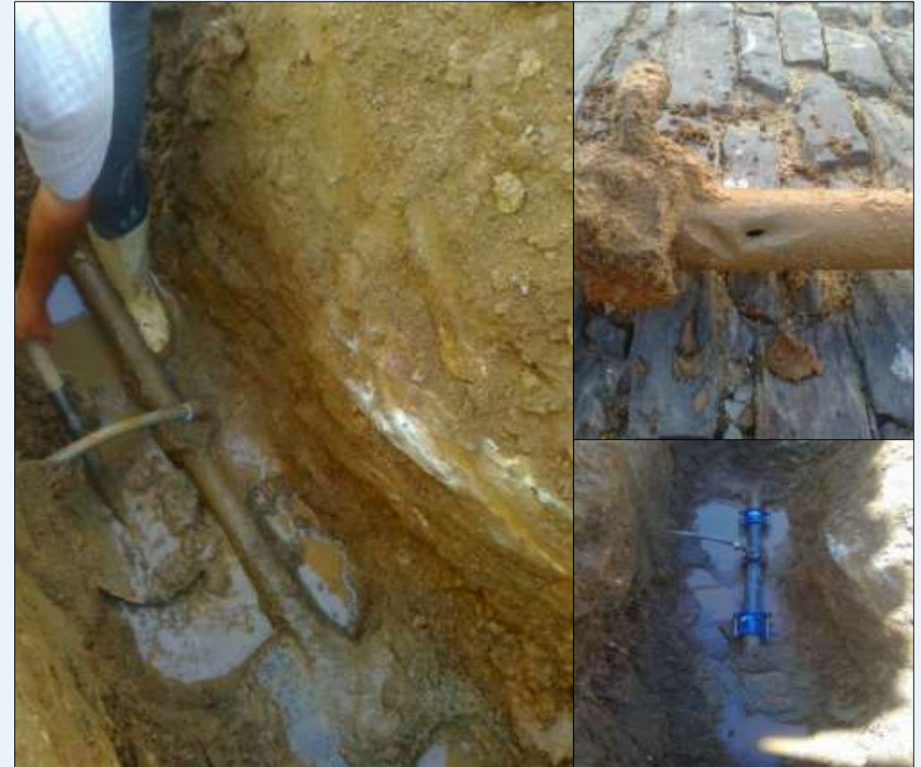
Reparação de uma rotura localizada na localidade de Perolivas (Reguengos de Monsaraz, 23/11/2016).
