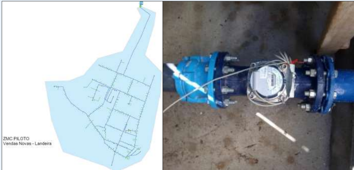
ZMC Piloto de Landeira e respetivo contador mecânico DN 100 mm (Landeira, Vendas Novas, 20/05/2016)
